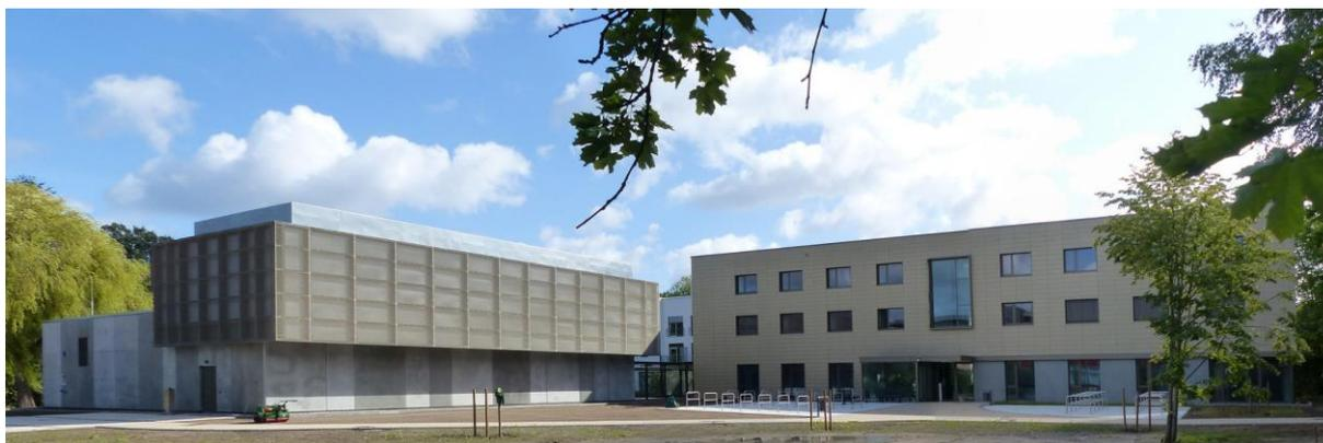
Abbildung 6.11 Neubau des Rechenzentrums mit Seminar- und Verwaltungsgebäude der Universität Greifswald, Beheizung des Seminar- und Verwaltungsgebäudes mit der Abwärme des Rechenzentrums
